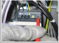
A l'aide d'un tournevis cruciforme, appuyer dans l'orifice et soulever le capot supérieur du variateur de vitesse (entrée variateur).
