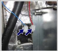
Desserrer les vis des barrettes de connexion sur le conducteur rouge et sur le bleu, à l'aide d'un tournevis cruciforme.
