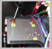
Appuyer à l'aide d'un tournevis dans l'ouverture correspondante (2B7/2B8) et réarmer le LTS.
