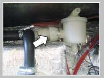
Desserrer le raccord de la sécurité anti-retour d'eau par siphonage à l'aide d'une pince multiprise.
