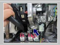
Desserrer les deux vis de l'attache du ventilateur à l'aide d'un tournevis à douille de 8.
