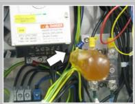
Desserrer la vis du bas sur le variateur de vitesse à l'aide d'un tournevis à douille de 7.
