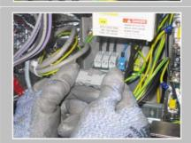
Détacher le multi-connecteur de l'arrivée moteur.
