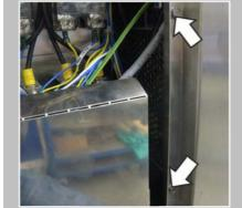
Desserrer les deux vis à l'angle droit du boîtier extérieur à l'aide d'un tournevis à douille de 7.
