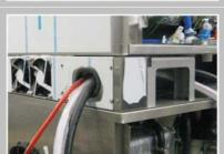
Passer les branchements d'eau et de nettoyant ainsi que tous les câbles à travers l'ouverture du capot arrière. Veiller à l'installation correcte conformément au manuel d'installation de votre four mixte et vérifier l'étanchéité des raccords d'eau et de nettoyant.
