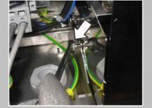
Sur le côté gauche du caisson d'air neuf, dévisser la vis de 8 :
