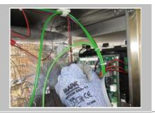
Débrancher la sonde (X10) sur le module de commande.
