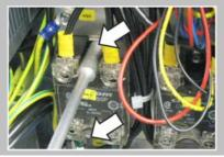
Desserrer la vis du bas à l'aide d'un tournevis à douille de 7. Ne pas ôter la vis du bas.
