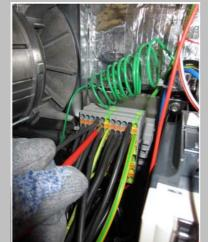
Débrancher les 6 câbles de l'élément chauffant de la chaudière.
