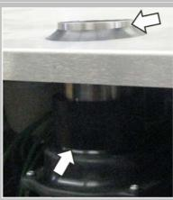
Remplacer le manchon d'aération par un manchon fourni et remettre en place le collier de tube en sous-face du capot extérieur.
