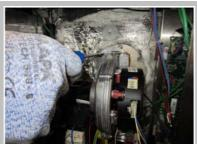
Dévisser complètement les deux vis de gauche sur la bride du ventilateur à l'aide d'un tournevis à douille de 9. Desserrer les deux vis de droite.
