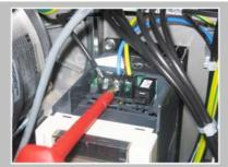
Desserrer tous les câbles arrivant sur le variateur de vitesse à l'aide d'un tournevis cruciforme.
