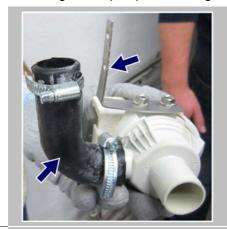
Installer l'équerre de maintien et le coude de vidange sur la nouvelle pompe de vidange de chaudière.
