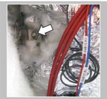
Desserrer la vis en haut sur la chaudière à l'aide d'un tournevis à douille de 10.
