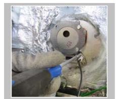
Ôter les deux vis à l'aide d'un tournevis à douille de 5,5.
