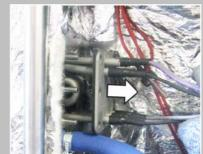
Retirer l'élément chauffant de chaudière.
