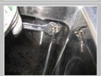
Serrer le raccord extérieur à l'aide d'une clé polygonale coudée ou d'un tournevis à douille de 24.
