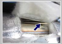
Ouvrir l'isolant en partie haute à l'aide d'un Couteau à lame rétractable et sortir le tube capillaire du LTS hors du ressort en tôle.
