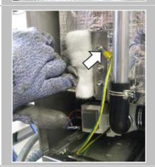
Desserrer le câble de masse sur la chaudière à l'aide d'un tournevis à douille de 10.
