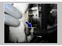
Lors de la mise en place du brûleur de la chaudière, appuyer les colliers de tube vers le bas.
