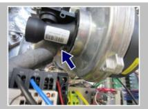
Desserrer la vis de maintien à l'aide d'une clé plate de 8.
