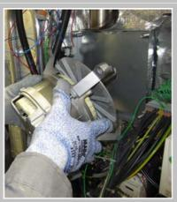
Sortir le moteur par l'arrière. Lors de l'extraction du moteur, veiller aux joints
