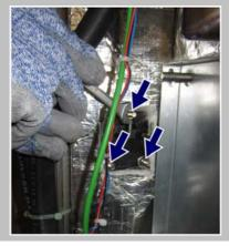
A l'aide d'une clé plate de 10, desserrer les trois vis (M6) de la sonde de niveau d'eau.
