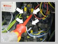
Enlever les 4 câbles sur le relais statique à l'aide d'un tournevis cruciforme.
