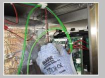
Débrancher la sonde (X1) sur le module de commande.
