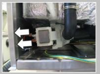
Retirer les deux connecteurs sur la pompe de vidange de chaudière.
