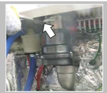
Desserrer la vis du collier de tube sur le piquage de déshumidification à l'aide d'un tournevis à douille de 7.
