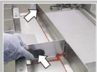
Ouvrir la membrane aux deux endroits à l'aide d'un couteau à lame rétractable.
