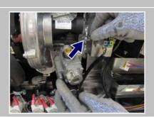
Enlever les deux attaches de maintien du ventilateur. Retirer simultanément la vanne de gaz.
