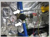
Desserrer les deux colliers de tube à l'aide d'un tournevis à douille de 7.
