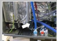
Retirer le tuyau sur le coude de vidange de la chaudière.
