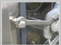
Sortir la gâche en la tournant à l'aide d'une clé plate de 12.
