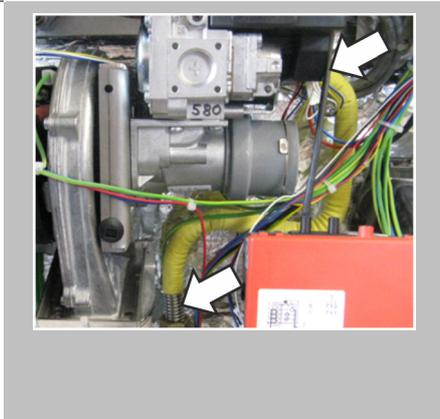
Vérifier l'étanchéité gaz des lignes de gaz, les raccords et capots du raccordement de l'appareil jusqu'aux vannes de régulation de gaz.
